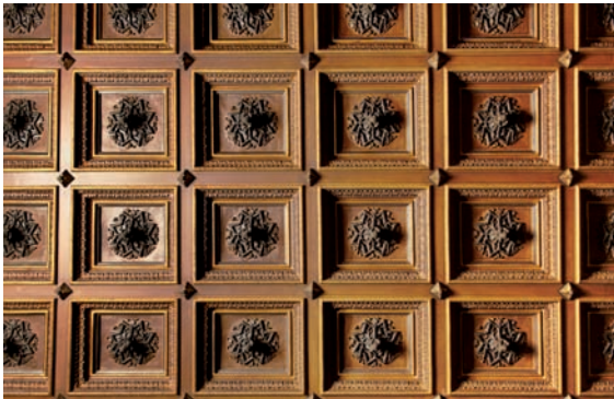
Detall del teginat de fusta tallada amb casetons ornamentals del sostre del menjador
