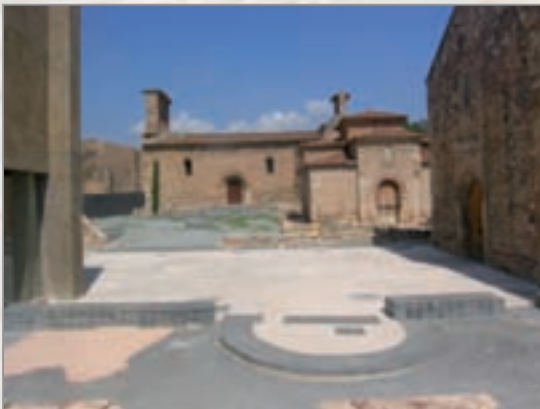
Recinte amb la nova pavimentació. MdT
