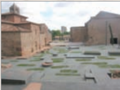
Recinte amb la nova pavimentació. MdT
