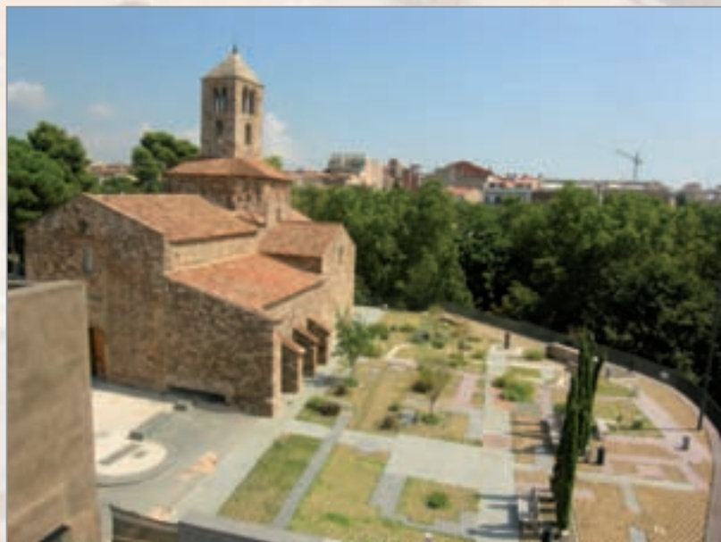
Recinte amb la nova pavimentació. MdT
